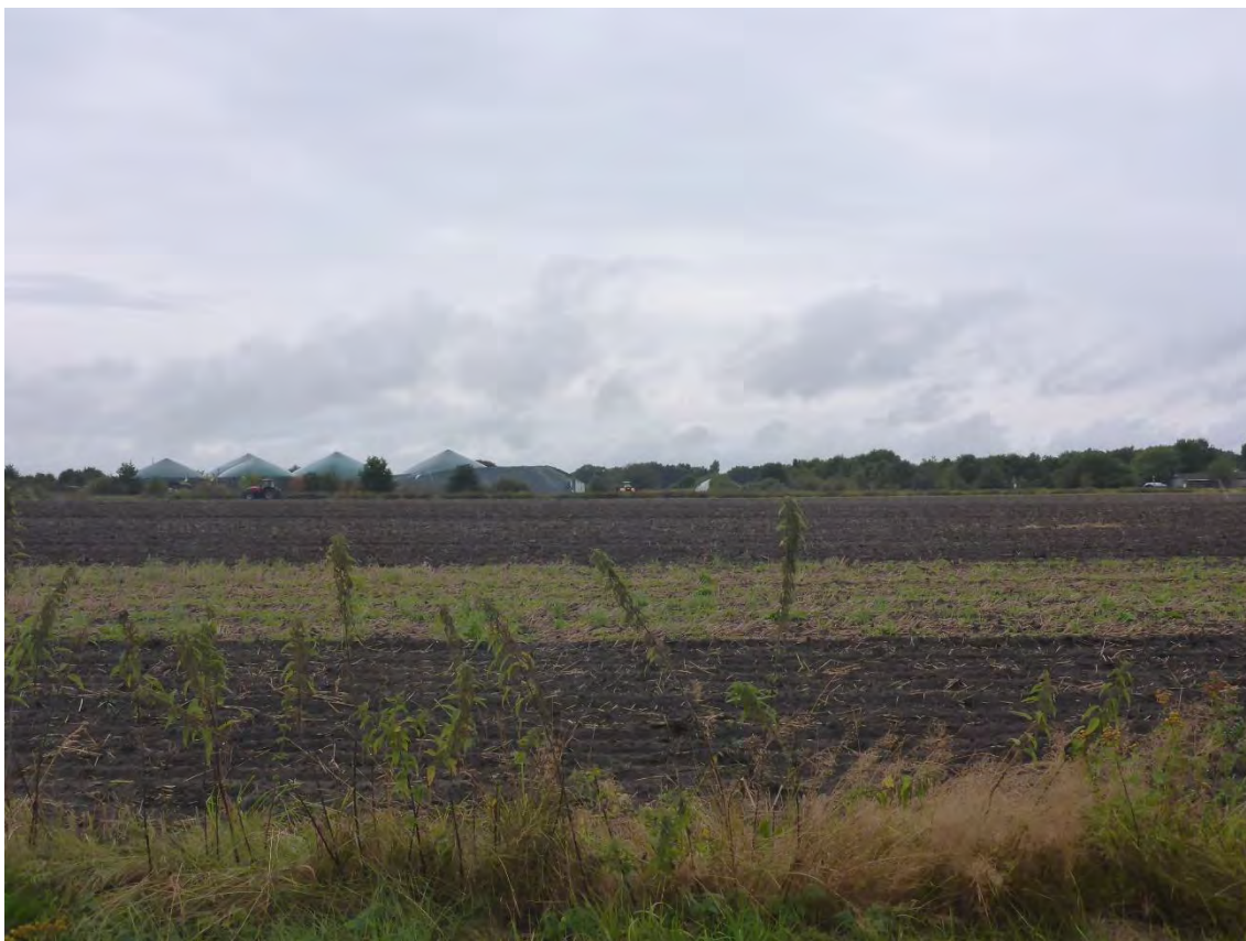
Abbildung 3-14: Blick auf die Biogasanlage im Nordwesten
